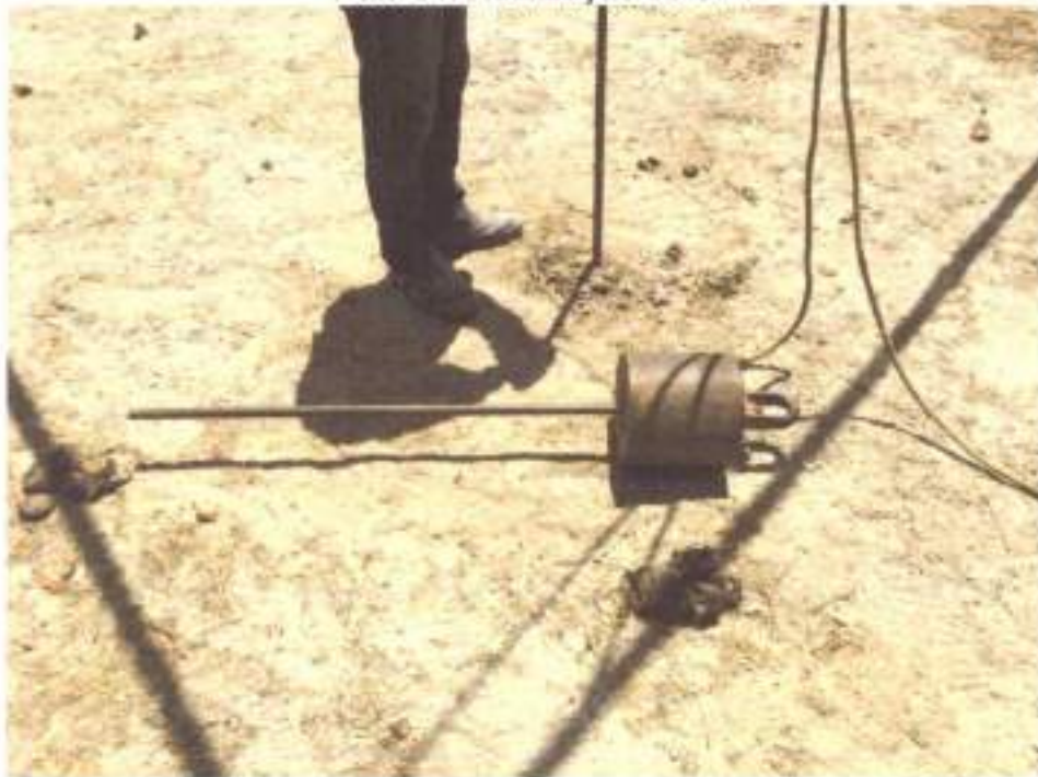
Foto 02: Equipamentos utilizados para a realização de SPT
