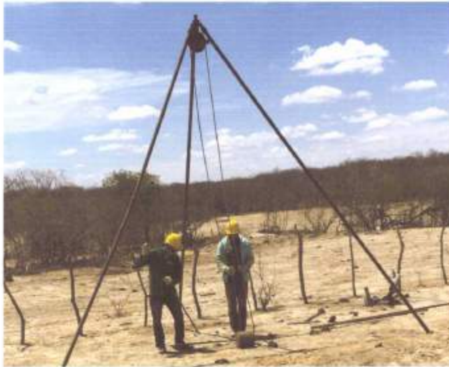
Foto 01: Realização de SPT
